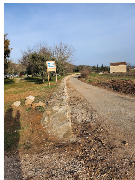
Le mur du GIET terminé
