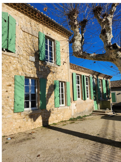
Nouvelles peintures des volets de l'ancienne école
